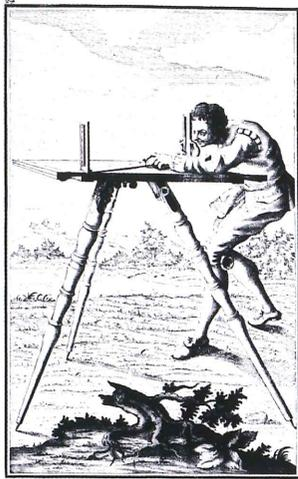
Abb. 2: Messtischaufnahme aus dem Originalband
