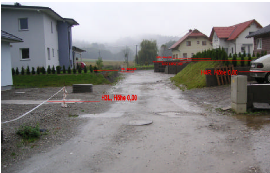
Abb.1: Straße mit Neubauten in fast ebenem Gelände mit sowohl in Längsrichtung, als auch zum gegenüber befindlichen Haus stark divergierenden Null-Höhen.
